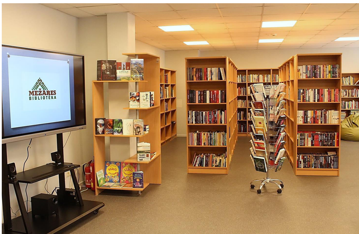
Mežāres bibliotēkas apvienotās telpas ar aprīkojumu pēc iekaramo griestu ar LED gaismas ķermeņiem izbūves, sienu un grīdas atjaunošanas remontdarbiem /Foto: J. Pastars/
