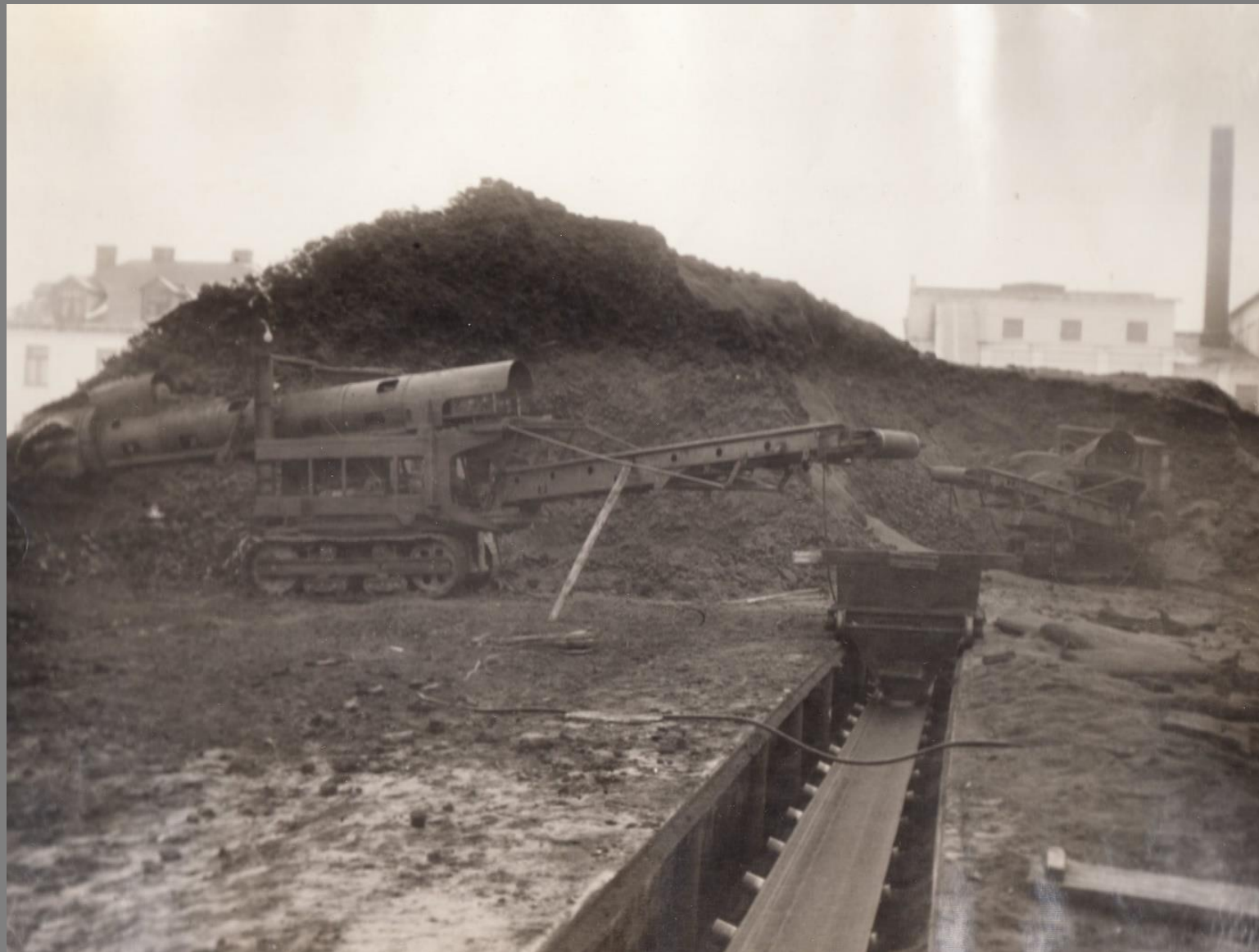
Akmeņogļu padošana uz katliem apkurei
